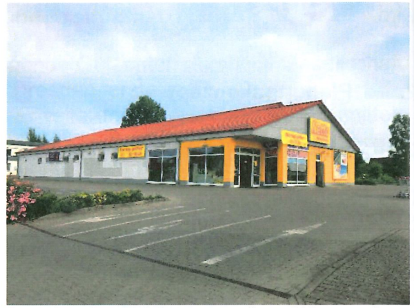
Bestehende Zufahrt von der „Wismarschen Straße“, eig. Aufnahme
