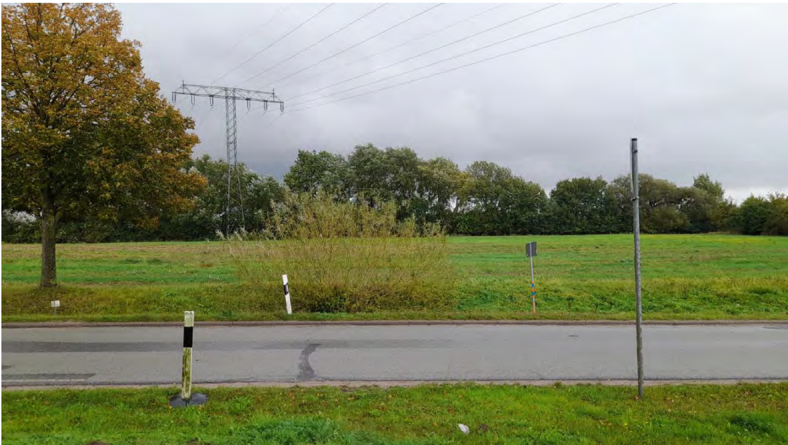
Abbildung 15: Blick auf die querende 110 kV-Freileitung. Foto: 10.10.2024.
