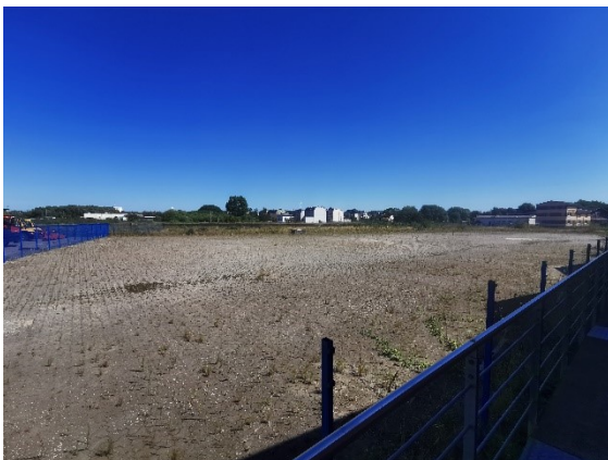
Foto 3: Blick auf die versiegelten ehemaligen Bahnbetriebsflächen
