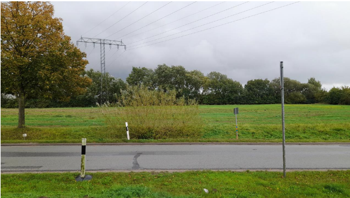
Abbildung 15: Blick auf die querende 110 kV-Freileitung. Foto: 10.10.2024.
