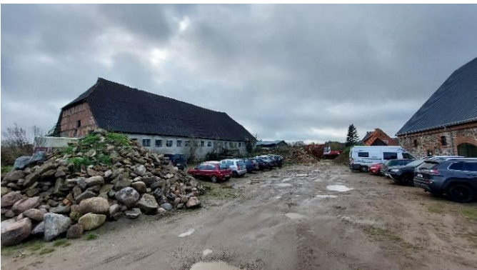
Platz zwischen sanierter und baufälliger Scheune
