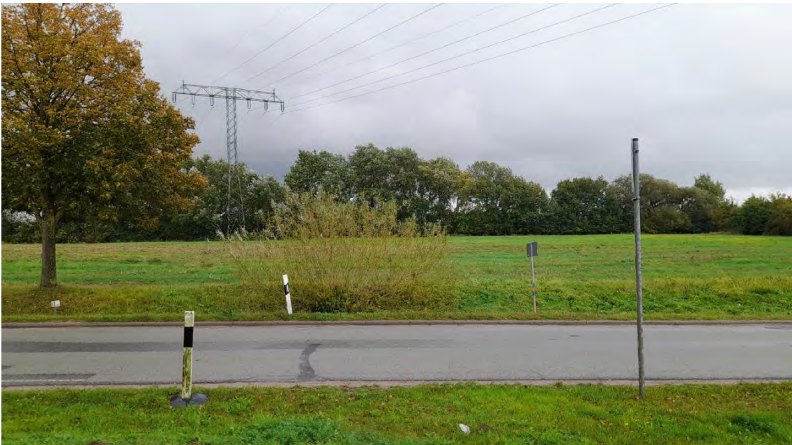
Abbildung 15: Blick auf die querende 110 kV-Freileitung. Foto: 10.10.2024.
