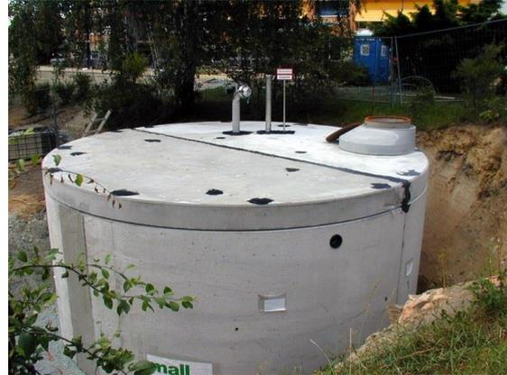
Abbildung 15 Unterirdischer Löschwasserbehälter
