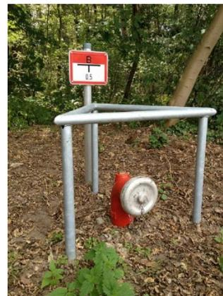
Abbildung 17 Löschwasserbrunnen ohne Tiefpumpe
