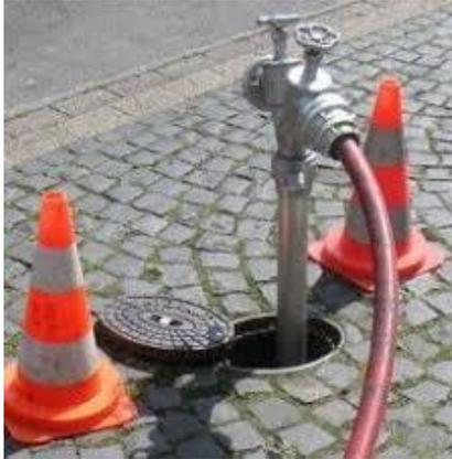
Abbildung 14 Unterflurhydrant mit Standrohr
