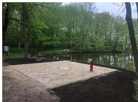
Abbildung 39 Entnahmestelle am offenen Gewässer
