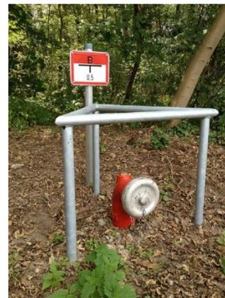
Abbildung 37 Löschwasserbrunnen ohne Tiefpumpe
