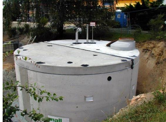
Abbildung 35 Unterirdischer Löschwasserbehälter
