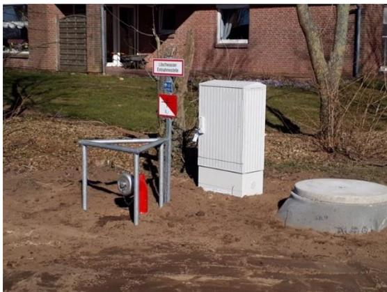
Abbildung 36 Löschwasserbrunnen mit Tiefpumpe
