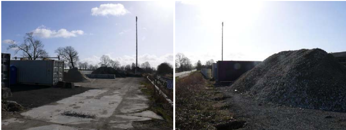
Abbildung 9: links: vollversiegelte Betonfläche mit Lagercontainern, Schütthaufen und angrenzendem Gleisbett; rechts: Schütthaufen mit Lagercontainer und angrenzender B 105. Quelle: STADT LAND FLUSS 26.02.2021.
